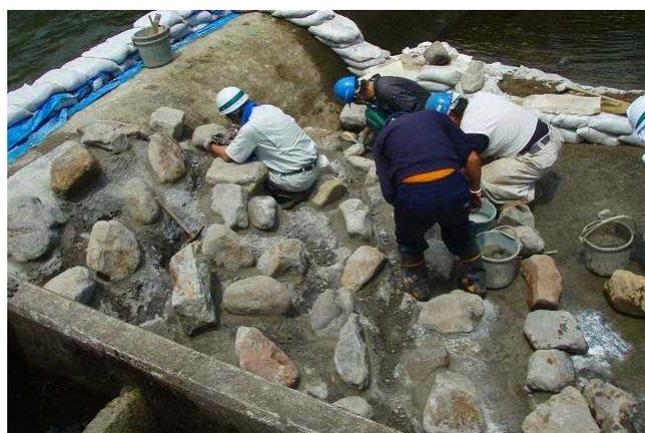
間詰めコンクリートで石を確実に固定
