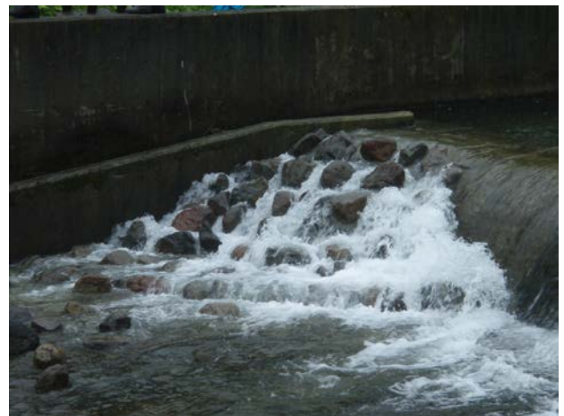
ボランティア魚道通水完了
