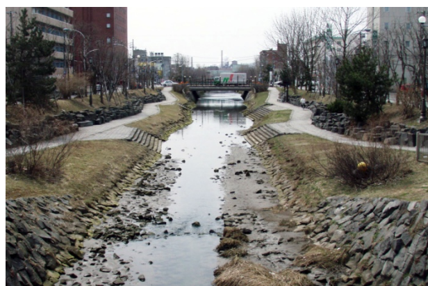
写真1 ー都市部における環境護岸
