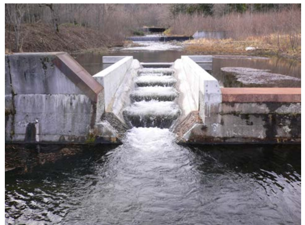
ウラップ川 No.1 魚道（平成19年施工）
