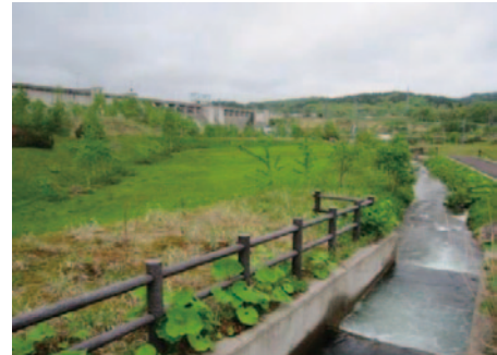
美利河ダム(奥)と魚道(手前)
