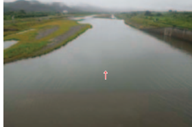
③ 千代田新水路(管理橋から下流方向を望む)
