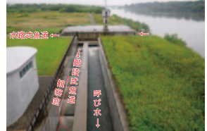
⑥ 魚道観察室(魚道断面観察室)
