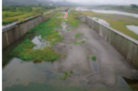
② 実験水路(管理橋から下流方向を望む)
