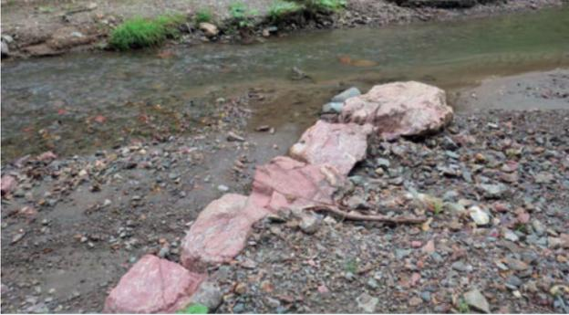
ここに巨石を置いて、画面の写真の右手側のほうに治山堰堤があって、左岸側のほうに魚道の入り口があるのですが、いつもこの滲筋が土砂の流出に伴って、左岸側だけではなく右岸側へと滲筋が変わっていたところもありますので、巨石を半分以上埋め込んでいただいた形で、すこし水制工のように張り出して、こちらのほうに滲筋が普段落ち着くようにすると。見ての通り、そんなに大きく出っ張らせていませんので、増水すると上からも乗り越えています。ですから、普段の時にここに寄せればよだけで、増水時に過剰に高さを上げてしまうと、ここにまた大きな堆積が起きて、どんどん増水時もここしか流れなくなって、河床の大きな負担というのがかかってしまう。そういうことがないように、なっている所であります。そのような、石組みのやることの利点というのは、あるわけですがどこにヒントがあるのかと。先ほども言いましたように、実際の川の中でも石がこう組まれている。
