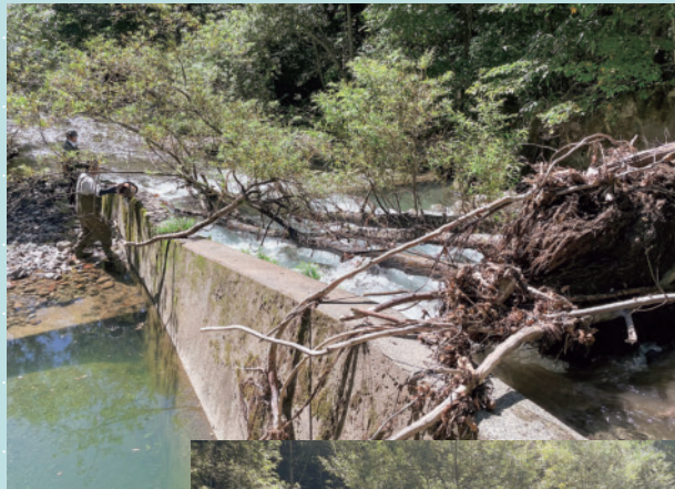
堰堤 No2 魚道清掃の様子（左）と清掃後
