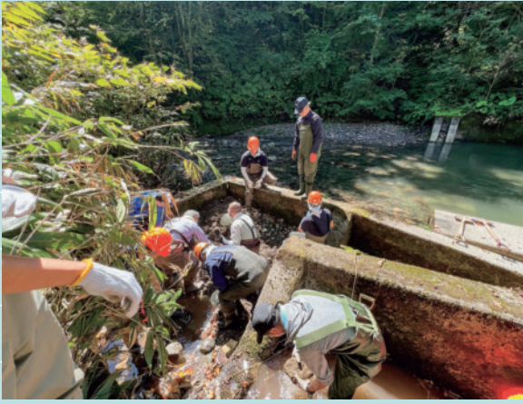
堰堤 No2 魚道清掃の様子（左）と清掃後
