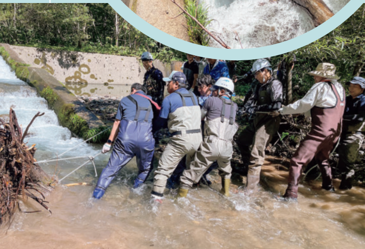
堰堤 No4 魚道清掃の様子と清掃後（左下）
