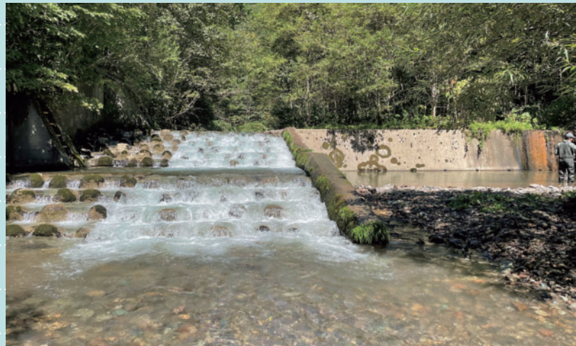
堰堤 No4 魚道清掃の様子と清掃後（左下）
